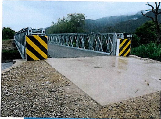
PUENTE PINDICUCHO Luz: 39.62 m AMAZONAS Costo de instalación S/ 628,844.59
