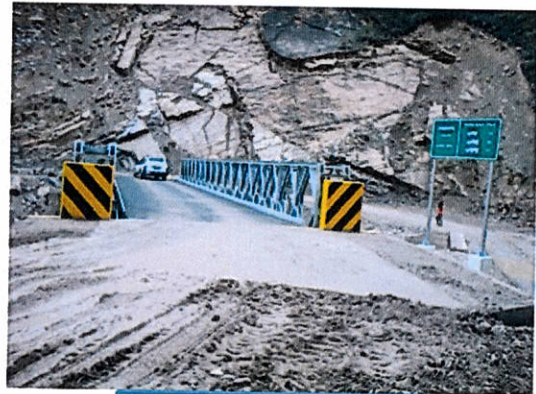
PUENTE LACHOG Luz: 24.38 m ANCASH Costo de instalación S/ 352,931.32
