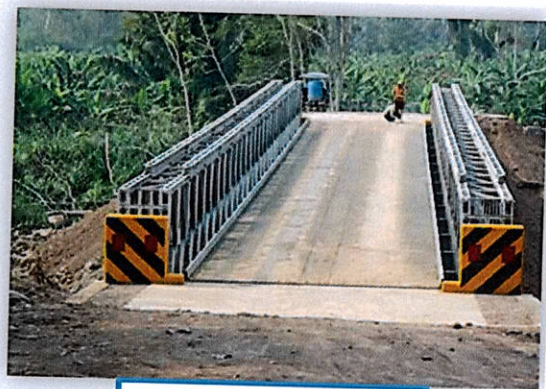
PUENTE CACHYACU Luz: 42.67 m SAN MARTÍN Costo de instalación S/
