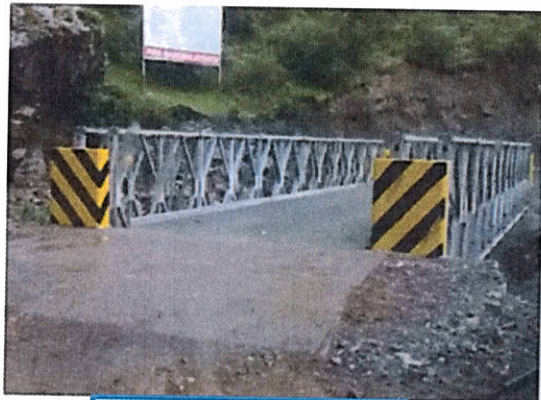
PUENTE ANAHUASI Luz: 18.29 m APURIMAC Costo de instalación S/ 487,582.03
