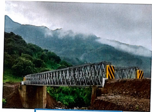
PUENTE SAPSE Luz: 42.67 m PIURA Costo de instalación S/ 549,737.39
