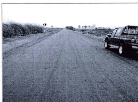
Camino Vecinal Caral – Supe (24.96 Km)
