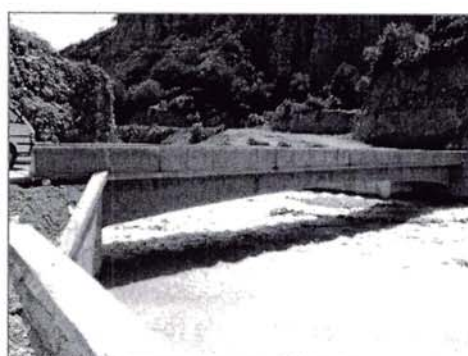
Puente Actuy (33.60 m) Departamento de Ancash, Provincia de Sihuas
