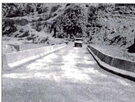
Puente Actuy (33.60 m) Departamento de Ancash, Provincia de Sihuas
