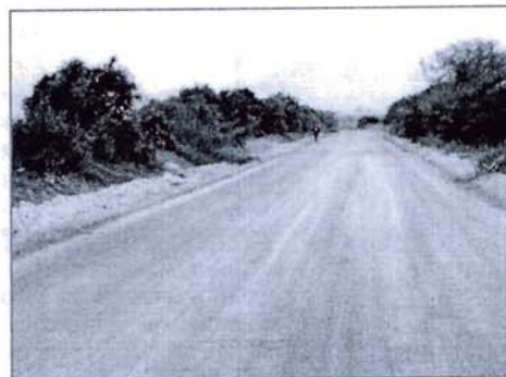
Camino Vecinal Caral – Supe (24.96 Km)
